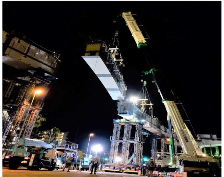
次に**ケーブルディレクション工法**。つり橋をイメージしてもらおうと思います。桁下に川などがある場合や谷間の場合などベントが設けられない場合に使われる工法です。ベントの設置が困難な場所に橋を架けられるのでケーブルディレクション工法は最大のメリットとされています。
